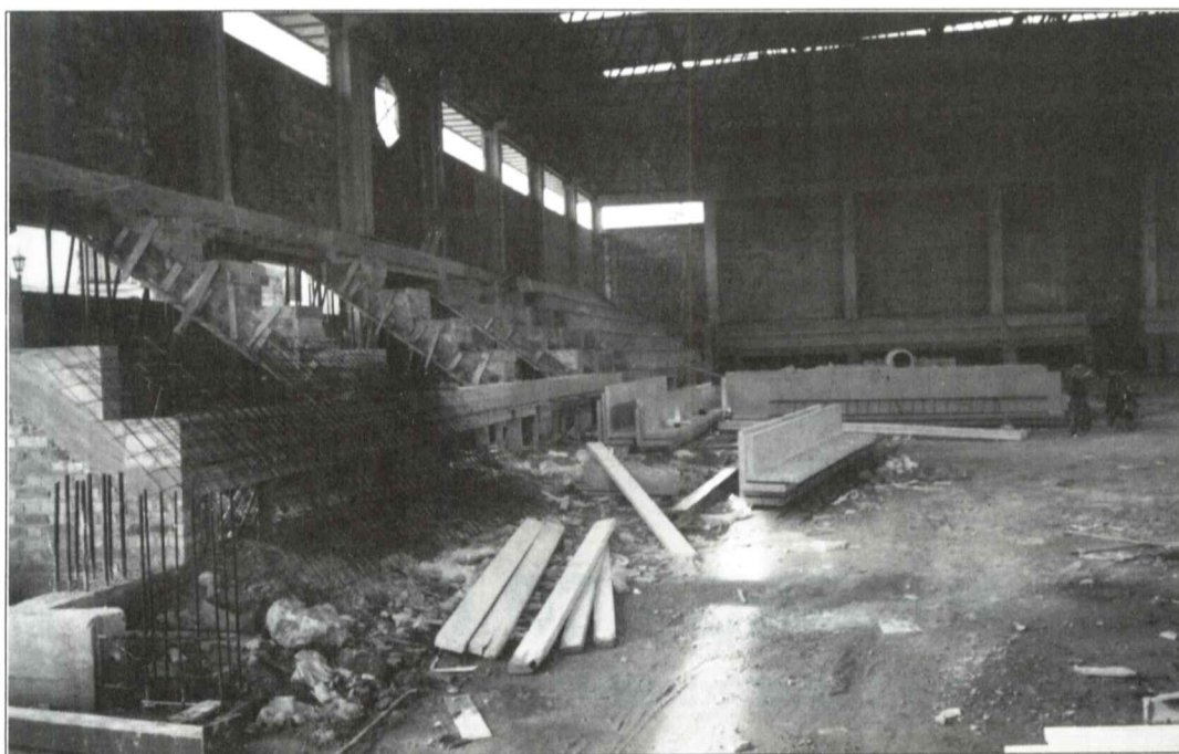
El pabellón polideportivo ha sido ya cubierto y en estos momentos se están cerrando los exteriores y se construyen los graderíos.
