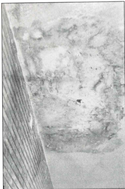
Techo que amenaza derrumbamiento.
