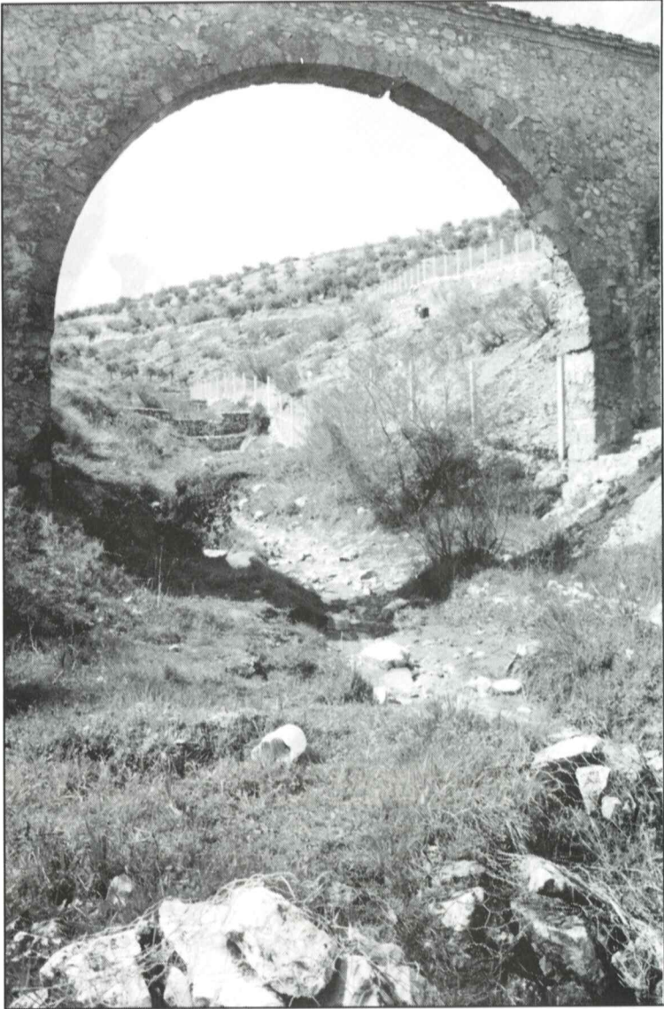
Foto 2.- Vista del arco. Al pie, uno de los gaviones derribados.
