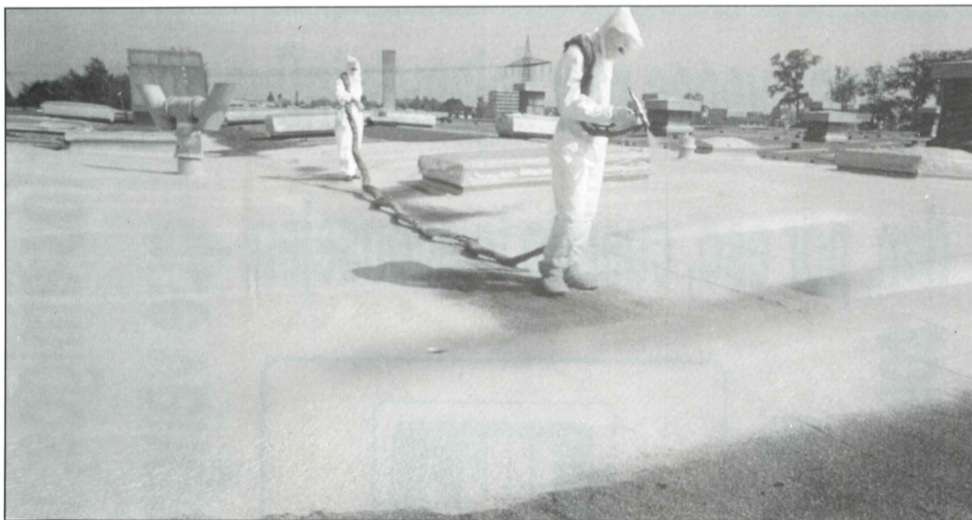
Proyección de Poliuretano - Impermeabilización y aislamiento térmico.
