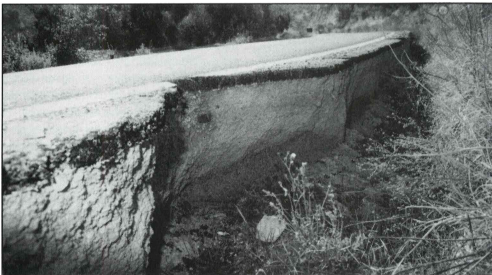
Carretera Priego-Zagrilla. Anchura de la carretera 4'50 metros. Desnivel en el arcén 80 cms.
