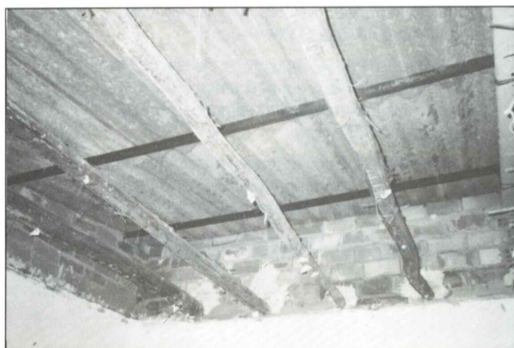
Techo derrumbado en el puesto de Cruz Roja.
