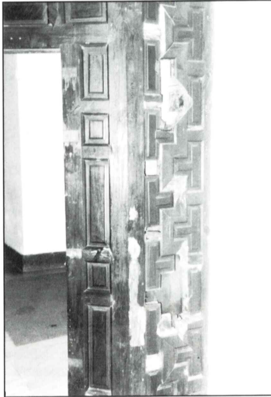
Cancel carcomido por las termitas y escalera de acceso a las cubiertas.
