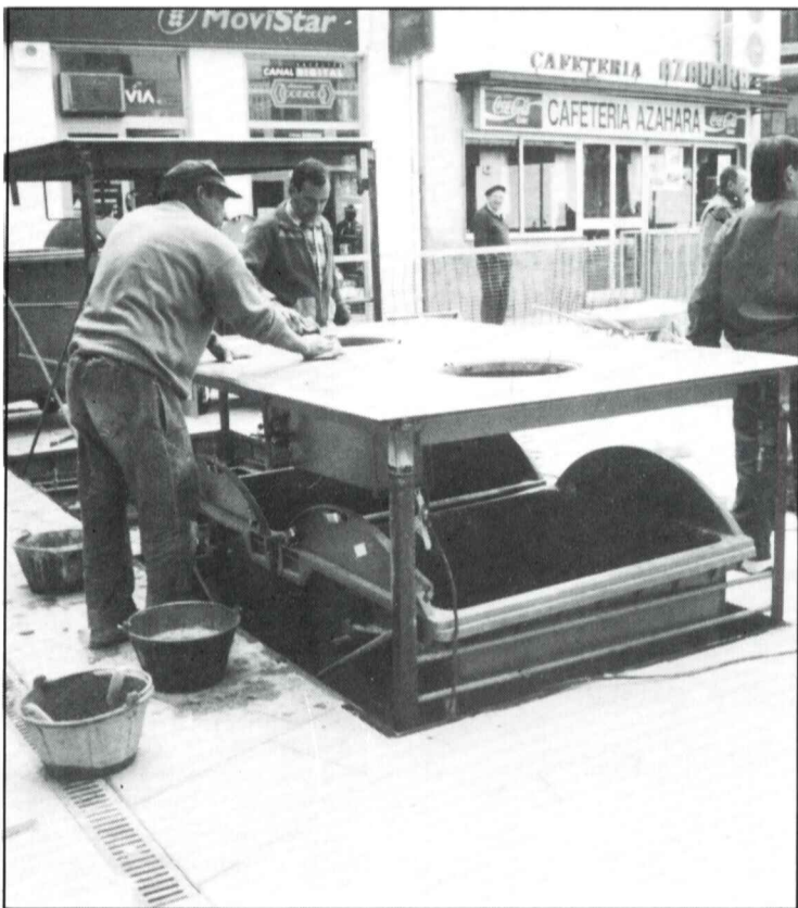
Obras de instalación, con la plataforma semielezada.
