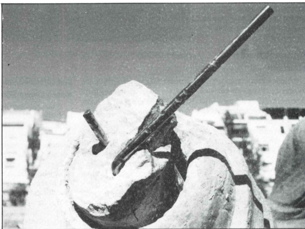
El perno de hierro ha sido sustituido por acero inoxidable.
