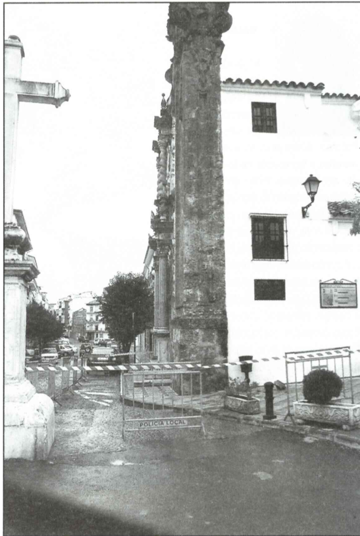
Tosco desprendido de la espadaña de la Aurora. A la derecha vallada para proteger a los viandantes.
