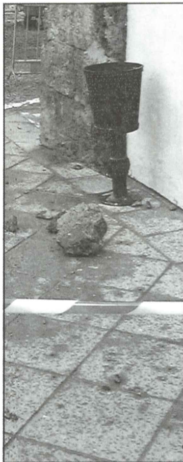
Tosco desprendido de la espadaña de la Aurora. A la derecha vallada para proteger a los viandantes.
