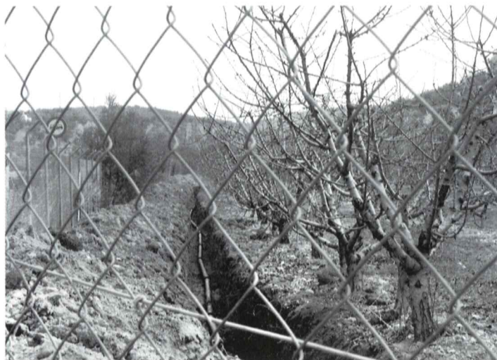
Nueva tubería de abastecimiento de agua potable (Castellar)
