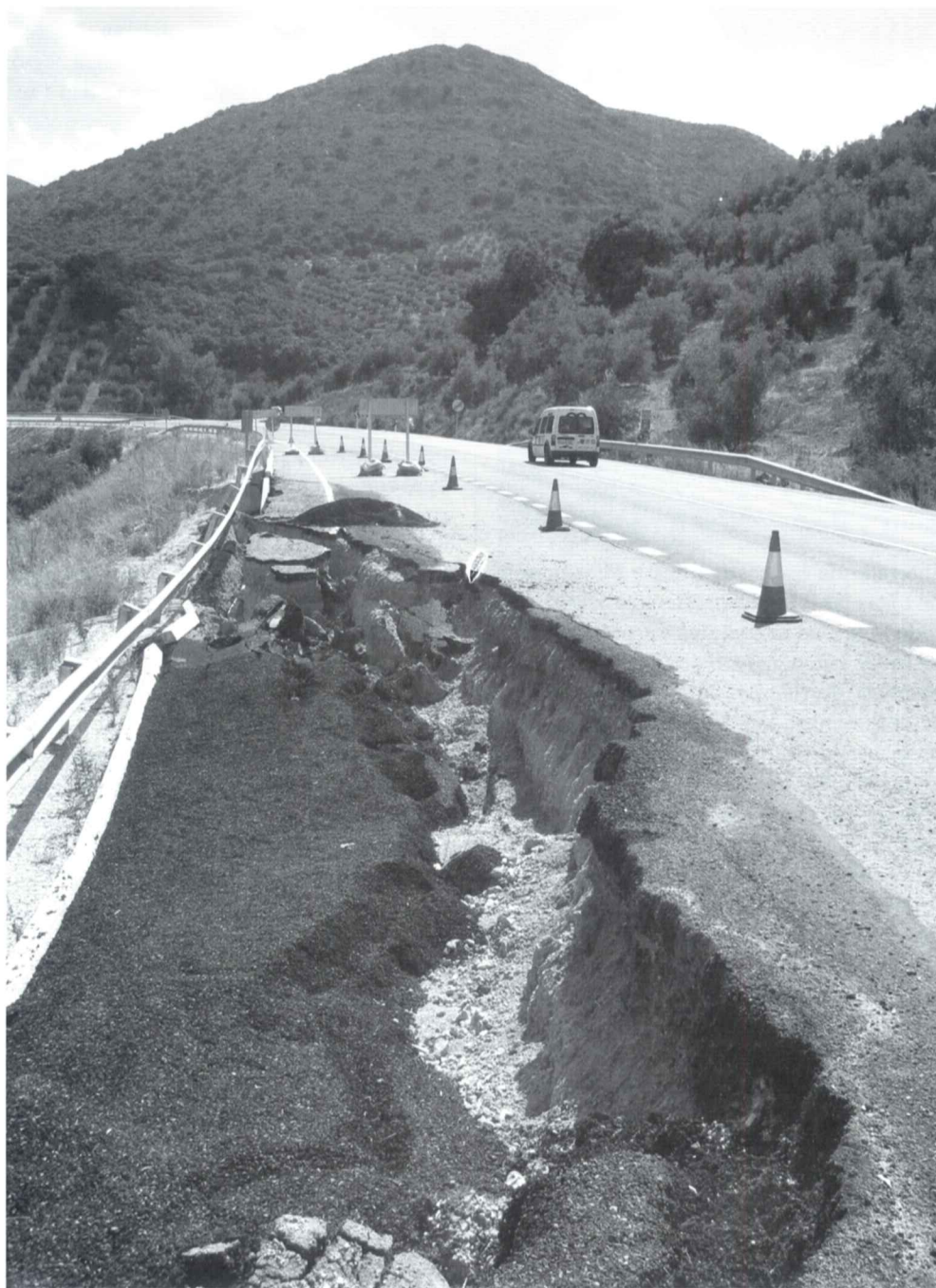
Hasta la presente sigue el hundimiento en el kilómetro 11 de la A-339 subiendo al Mojón. foto: M.Molina
