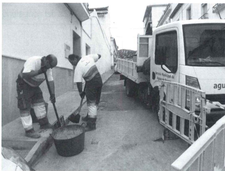
Dos operarios de Aguas de Priego realizando tareas de limpieza de imbornales
