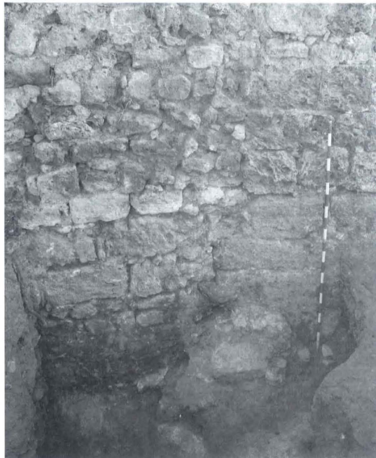
Muralla recayente al Recreo de Castilla (Adarvillo), una vez limpia. En primer término, sólo las primeras hiladas de sillarejos, que sobresalen, corresponden a la muralla medieval, el resto es un rechecho muy posiblemente de la época de construcción del Recreo en el siglo XIX.
