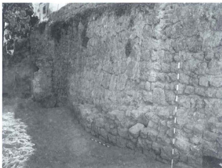
Muralla recayente al Recreo de Castilla (Adarvillo), una vez limpia. En primer término, sólo las primeras hiladas de sillarejos, que sobresalen, corresponden a la muralla medieval, el resto es un rechecho muy posiblemente de la época de construcción del Recreo en el siglo XIX.
