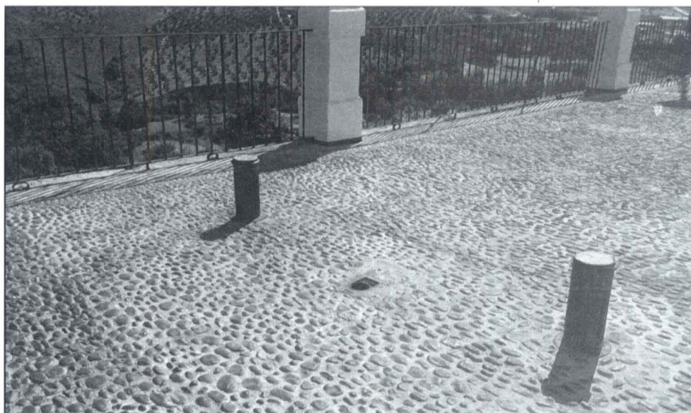
En la foto superior falta un pivote y en la inferior un barrote
