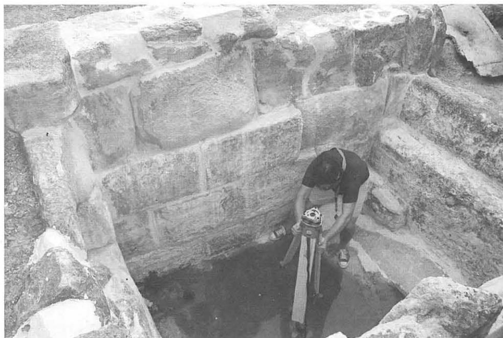
conservación y puesta en valor de la fuente, sin que hasta hoy se hayan podido ultimar debido a las graves patologías que presentan algunos de los sillares que componen la obra, muy erosionados, con fisuras estructurales y pulverización de la arenisca madre.
