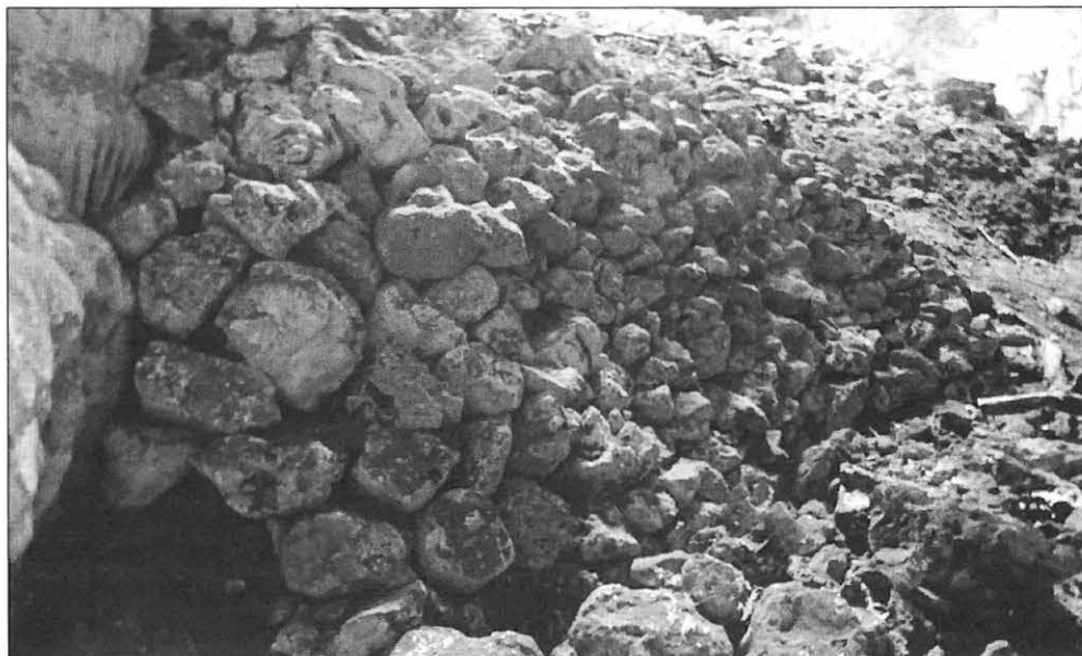
Primer muro de aterrazamiento (B) y fecha abajo a la izquierda
