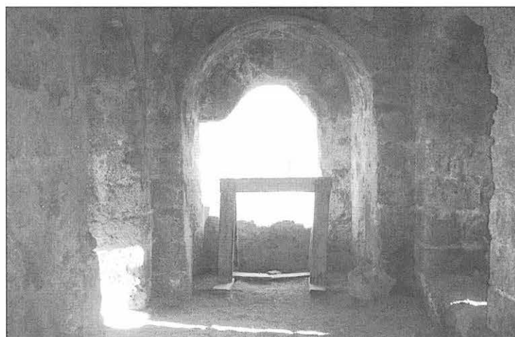
Vista del antes y después de la restauración y recuperación de las cámaras de tiro del interior de la Torre 2. Estas aspilleras, que estaban destruidas, y se han podido reconstruir gracias a que una de ellas se encontraba intacta; habiéndose ejecutado y tallado, en obra, y manualmente, todas las piedras de conformación de las mismas, una vez estudiada la geometría y tamaño de las piezas de la aspillera original.
