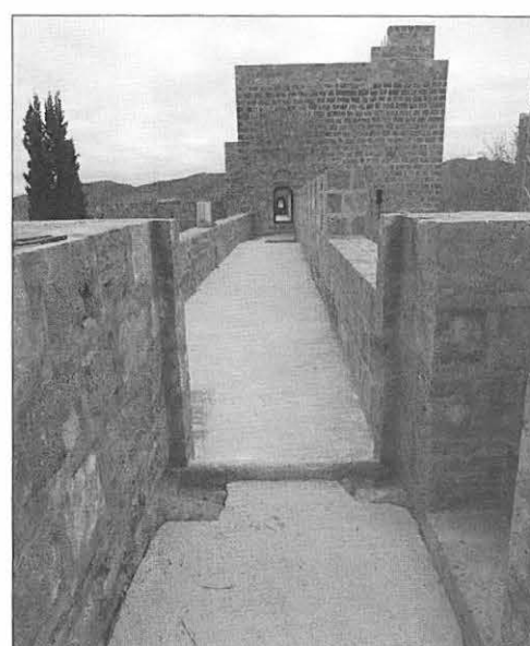
El Lienzo 1 y la Torre 2 vistos desde el interior de lo que fue la cámara de habitación de la Torre 1, ahora reconstruida hasta 1 metro de altura. Se destacan las jambas de la puerta de acceso, los goznes en el suelo de las puertas de madera que existían en su origen para entrar a la torre y la columna de mármol que se colocó, en su origen, a modo de escalón de entrada. A la izquierda el arranque de lo que fueron las escaleras de acceso a la terraza de la torre.
